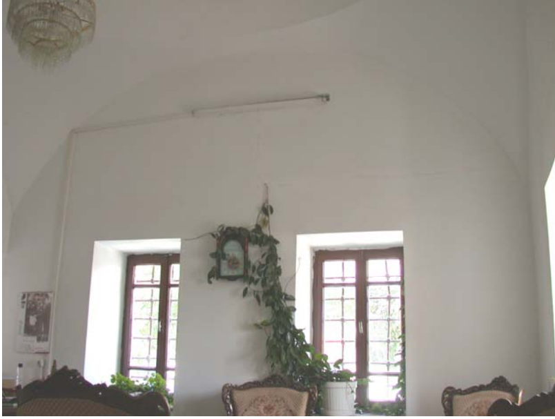
Res.19- Karavezir Seyyid Mehmet Pařa Medresesi Kütüphanesi, doęu duvarı.
