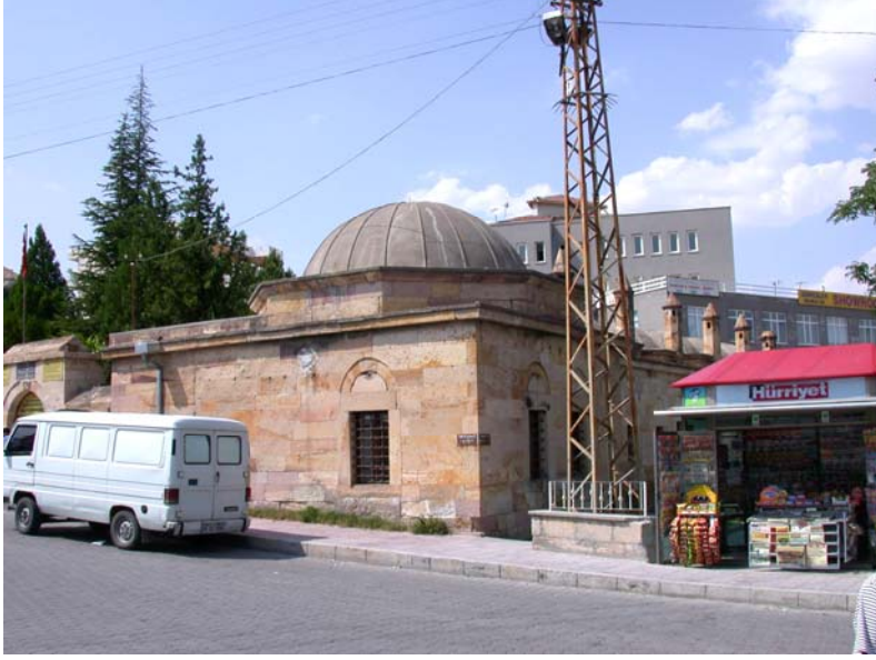
Res.15- Karavezir Seyyid Mehmet Paşa Medresesi Kütüphanesi, güneydoğudan görünüş.
