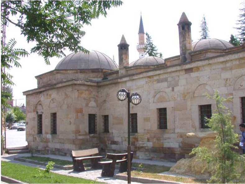
Res.16- Karavezir Seyyid Mehmet Paşa Medresesi Kütüphanesi, doğu cephesi.
