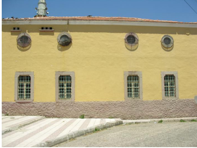
Fotoğraf 3- Güney cephesi.
