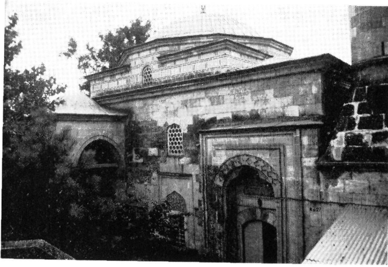
Res. 1- Şah Melek Camii, dođu cephe.
