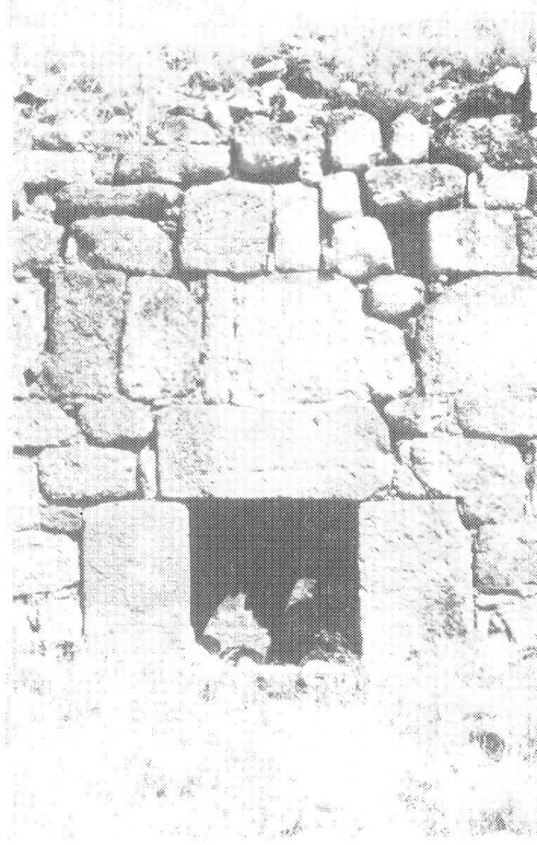
Res. 9- Kızılören Hanı Yakınındaki Yapı. Batı cephesindeki pencere.
