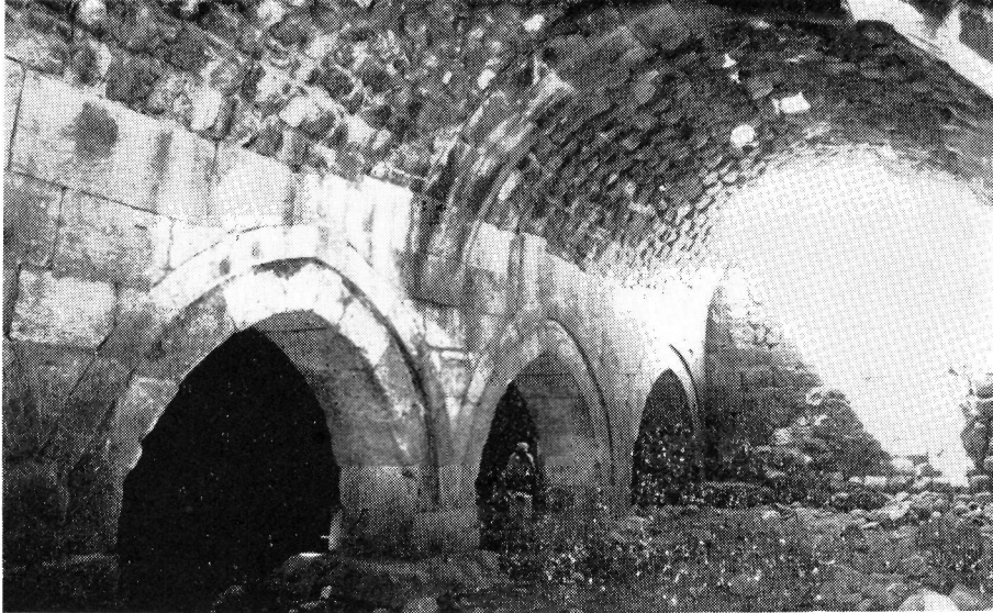
Res. 6- Kızılören Hanı Yakınındaki Yapı. Doğu sahininin kuzey ucunda, çatıya çıkan merdiven.
