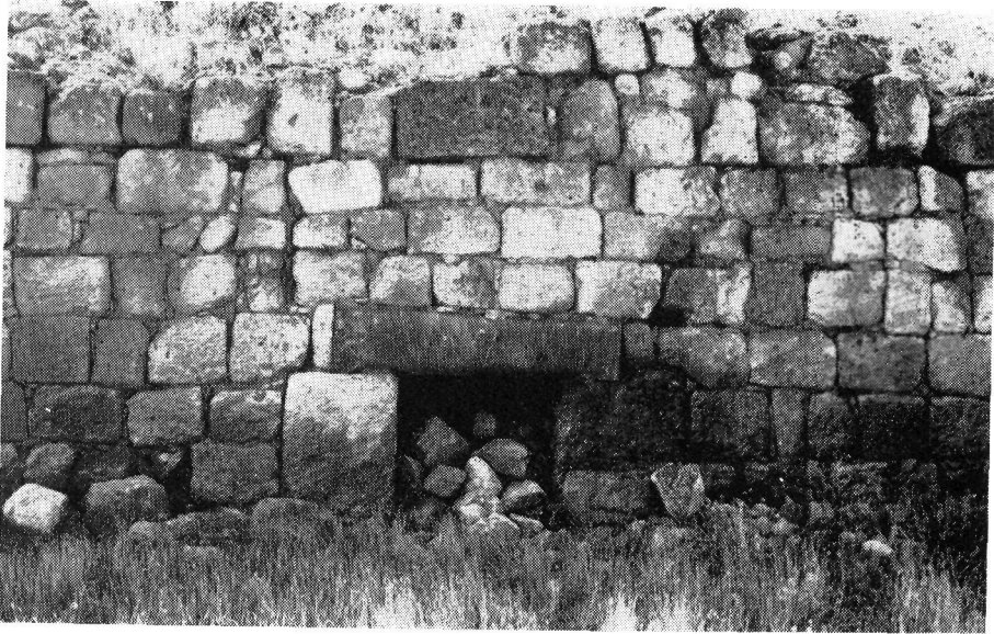
Res. 8- Kızılören Hanı Yakınındaki Yapı. Doğu cephesindeki pencere
