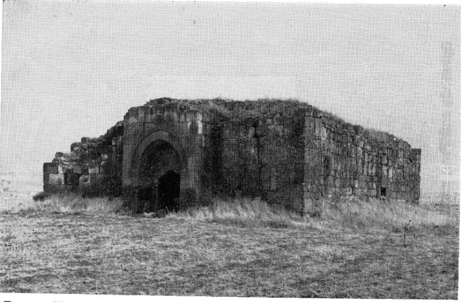
Res. 1- Kızılören Hanı Yakınındaki Yapı. Giriş ve batı cepheleri.
