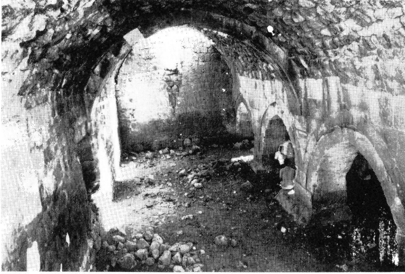
Res. 5- Kızılören Hanı Yakınındaki Yapı. Doğu sahinının güneye doğru görüntüsü.
