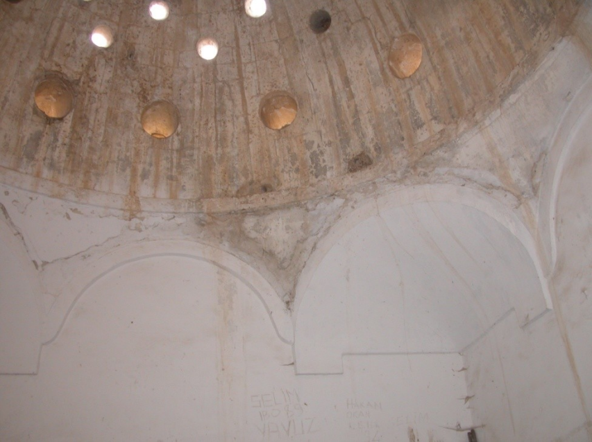
Fotoğraf 8: Hamamlı Köyü Hamamı, sıcaklık kısmının örtü sistemi.
