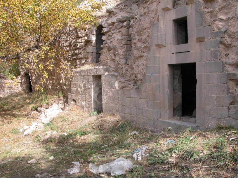
Fotoğraf 10: Yeşilburç Köyü Hamamı, güney (ön) cephe.
