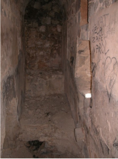
Fotoğraf 18: Yeşilburç Köyü Hamamı, sıcak su deposu.
