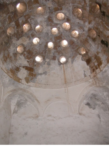
Fotoğraf 5: Hamamlı Köyü Hamamı, ılıklik kısmının örtü sistemi.
