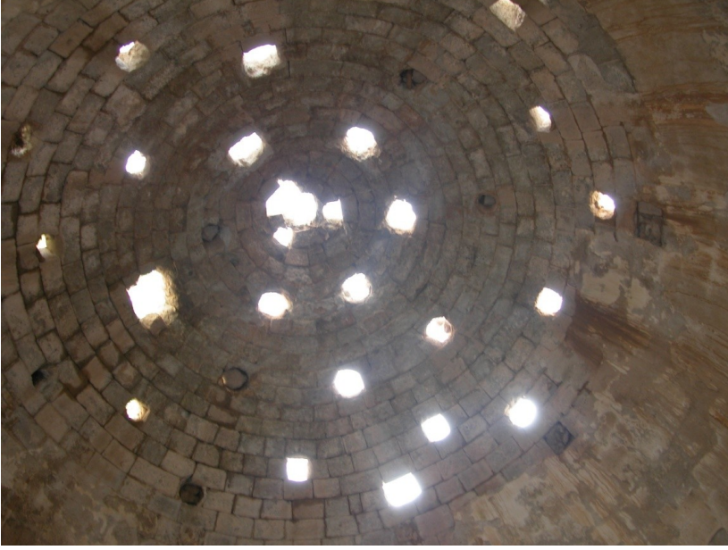
Fotoğraf 17: Yeşilburç Köyü Hamamı, sıcaklık kısmının örtü sistemi.
