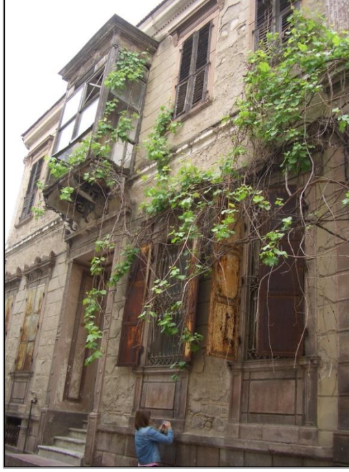
Res.7- 377 ada 23 parseldeki Rum konutunun genel görünüşü.
