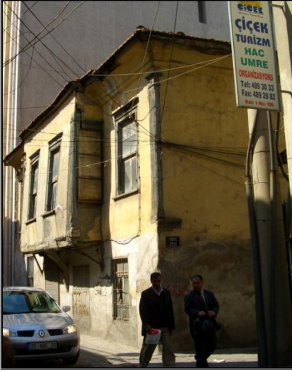
Res.2- 295 ada 5 parseldeki konutun genel görünüşü.
