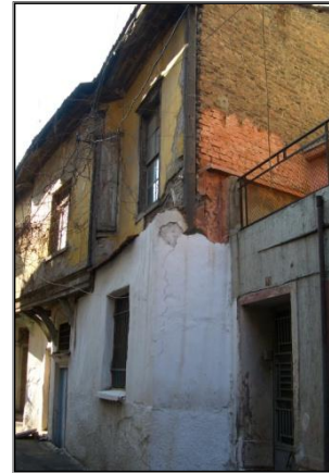
Res.5- 1546 ada 122 parseldeki konutun genel görünüşü.
