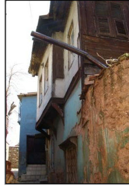
Res.6- 1551 ada 41 parseldeki konutun genel görünüşü.
