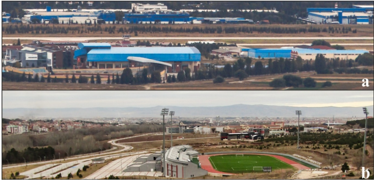
Şekil 7 a. ESTÜ 2 Eylül Kampüsü içerisinde yer alan havaalanı ve yakın çevresinin görünümü (bakış yönü: G, lokasyon bkz. Şekil 5a: F3) b. ESOĞÜ futbol stadyumu ve yakın çevresinin görünümü (bakış yönü: KD, lokasyon bkz. Şekil 5a: F4)
