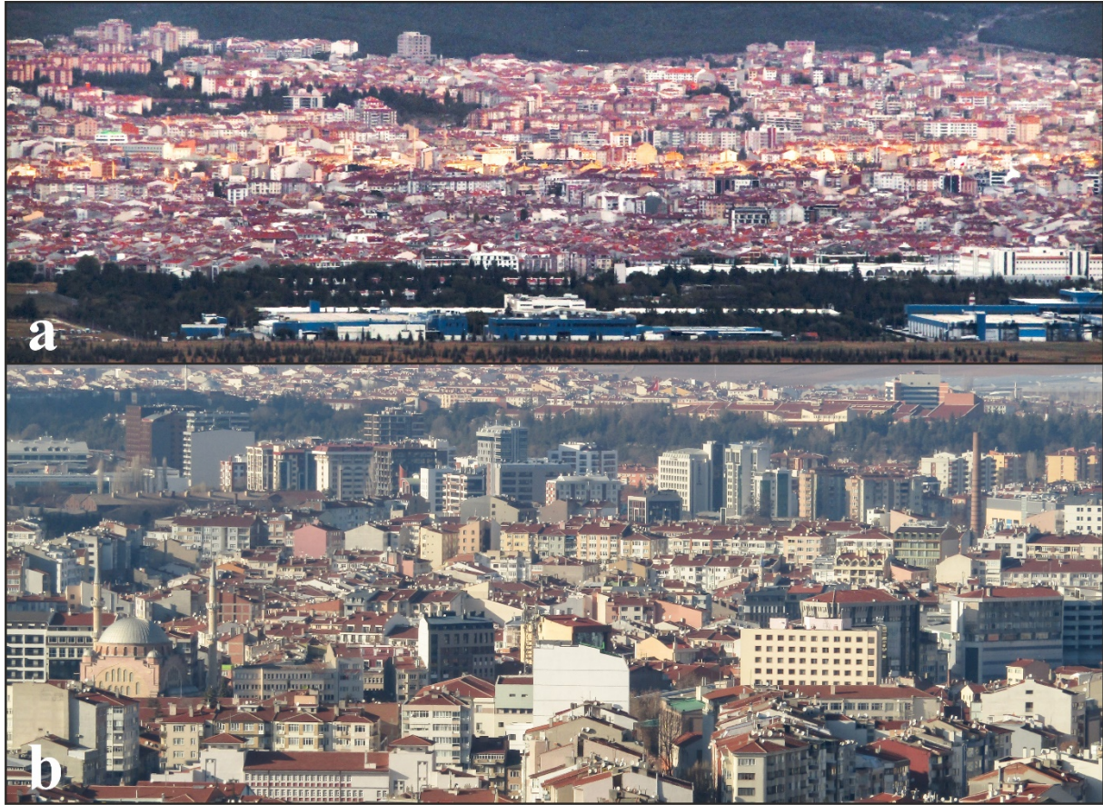
Şekil 3. a. Eskişehir kent merkezine ait kuzeyden bir görünüm (bakış yönü:G, lokasyon: bkz Şekil 2:F1) b. Eskişehir kent merkezine ait güneyden bir görünüm (bakış yönü:K, lokasyon: bkz Şekil 2:F2)
