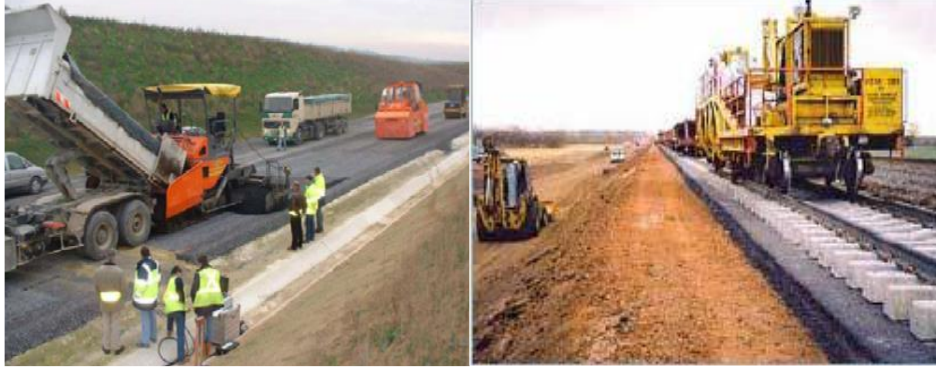
Şekil 2. İtalya yüksek hızlı demiryolu hattına asfalt kaplama tabakasının serilmesi [11].
