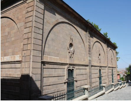
Fot.16: Güney cephesi.
