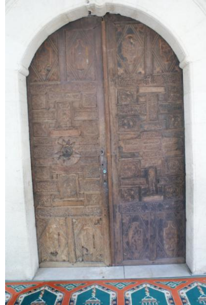
Foto 3: Kuzey kapıdan görünüm
