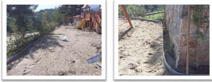
Şekil 10. Konut Projesinde çocuk oyun alanı çevre sınırlayıcı galvaniz ayraç uygulaması
