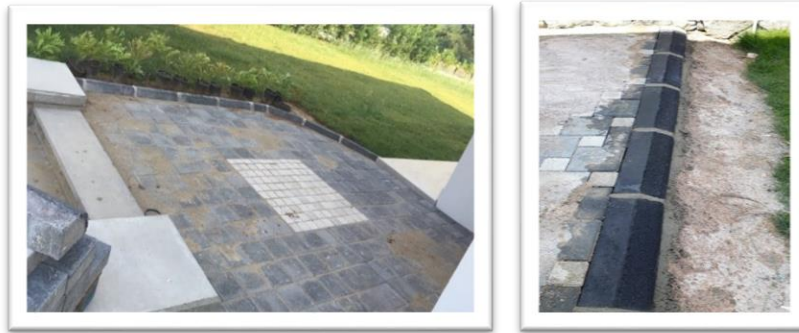
Şekil 6. Konut projesinde parke taşı ve bordür uygulaması
