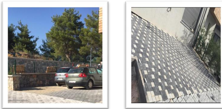
Şekil 11. Konut projesinde otoparklarda parke taş uygulaması
