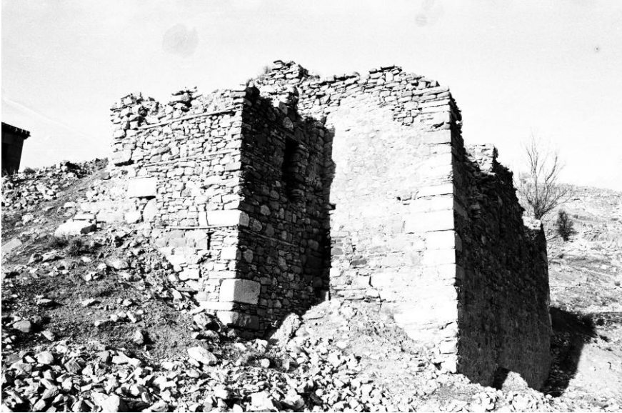
Levha 6. Medrese, Batı Cephe
