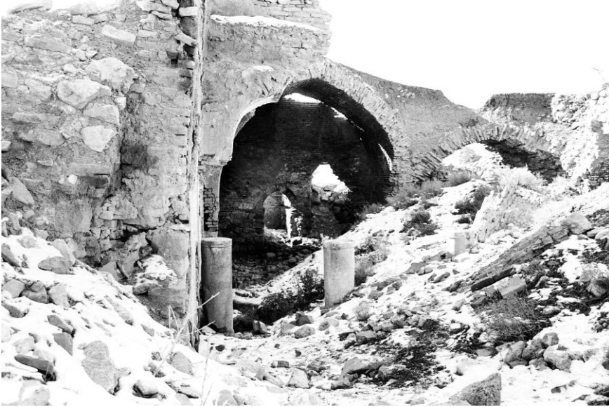
Levha 7. Medrese, Avlu, Genel Görünüm
