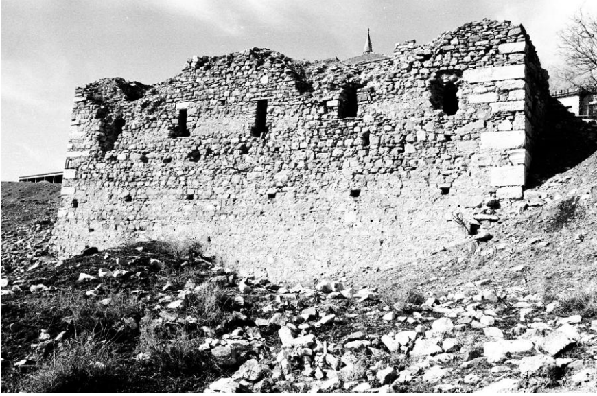
Levha 5. Medrese, Güney Cephe
