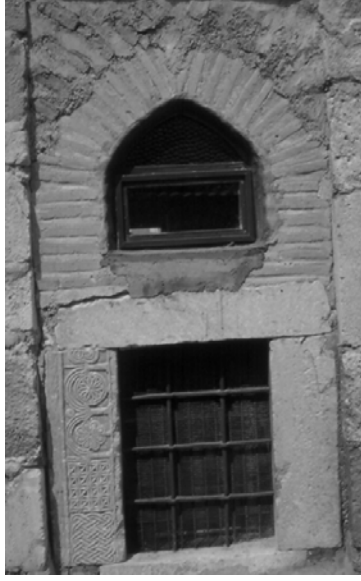
Resim 6. Güney cephe, pencere.
