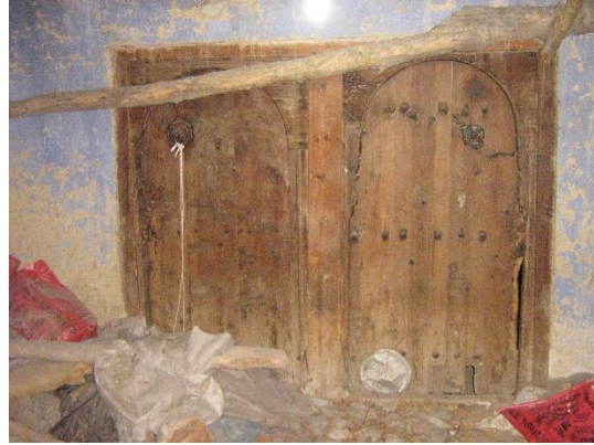
Fotoğraf 34: Zemin kattaki kemerli kapılar
