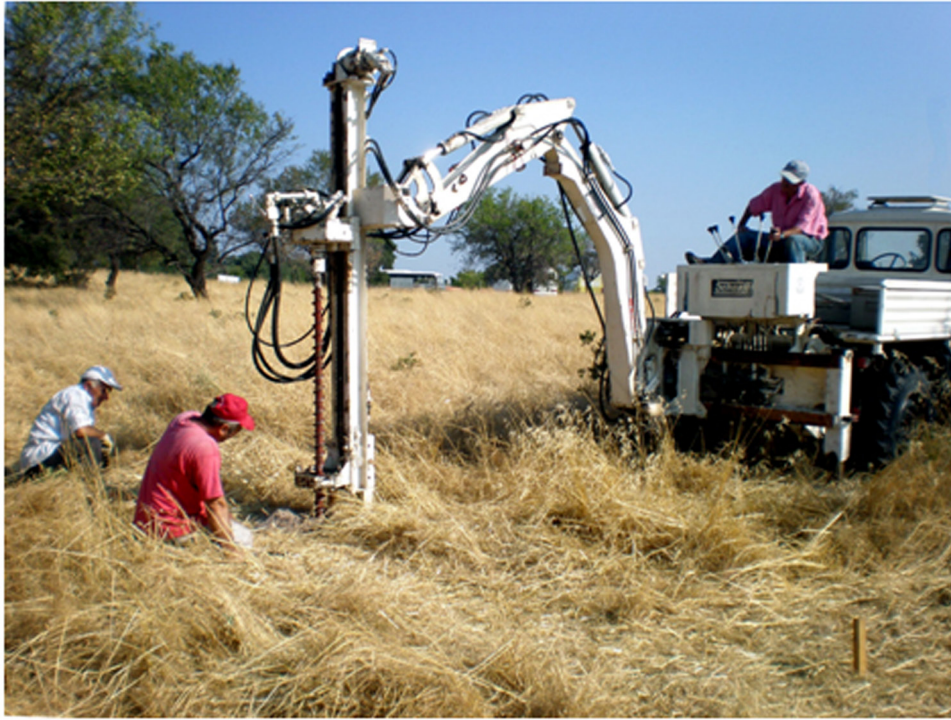
Fig. 4. Unimog iř makinesi ile yapılan burgu-delgi (auger drilling) alıřmaları.
