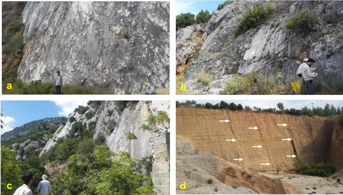
Şekil 5. Mermerlerde gelişmiş fay şevleri; yerleri Şekil 4'te verilmiştir. a) Dügerek köyü (bakış yönü KB'ya); b) Dügerek doğusu (bakış yönü K'e); c) Ortaköy doğusu (bakış yönü KB'ya); d) Ortaköy kuzeyindeki mıcır ocaklarında ana faya paralel gelişmiş kırıklar (bakış yönü G'e).
