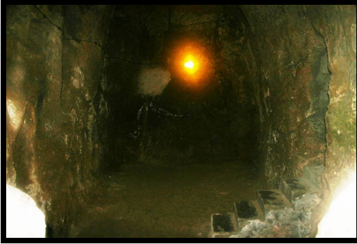
Resim 12: Odanın İçten Görünüşü
