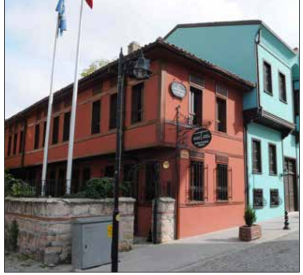
Fotoğraf 2. Birim Binası (öndeki koyu renkli bina)
