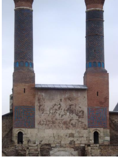
Resim 5. Çemberli ve çembersiz minarelerin, minare giriş kapılarının üstündeki yozlaştırılmış yazıların (arka cepheden) görünüşü. (M. Akar arşivinden)
