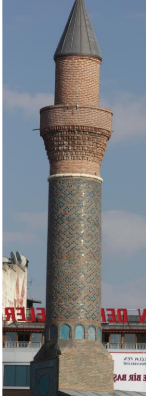
Resim 7. Çembersiz minaredeki yazının restorasyondan sonraki görünümü yukarıdaki fotoğraftaki gibi olmalıdır. Doğru şekli budur.
