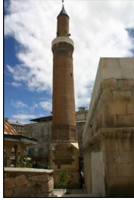
Şekil 12: Kuzey ve güney taçkapıları ve minare
