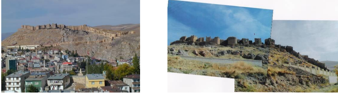
Şekil 7: Bayburt Kalesi surları ve burçları
