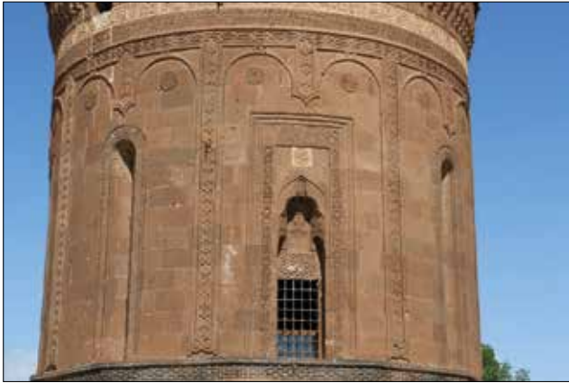
Fotoğraf 29: Ahlat Usta Şagirt Kümbeti çift kemer düzenlemesi / Double arch ornament in Ahlat Usta Şagirt Tomb
