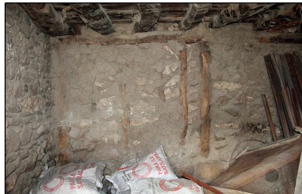
Fotoğraf 37: Ahşap Direkler / Wooden Pillars
