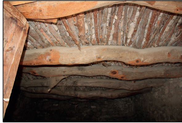
Fotoğraf 41: Taş Dolgulu Tavan Kirişleme / Stone Filled Ceiling Beams
