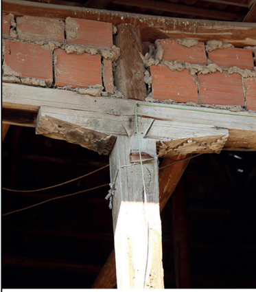
Fotoğraf 78: Ahşap Dikme Detayı / Wooden Pillar Detail
