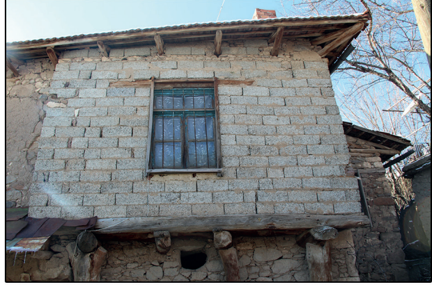
Fotoğraf 88: Tuğla Duvar Kaplaması / Brick Wall Cladding
