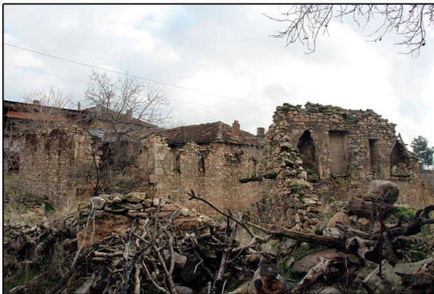
Fotoğraf 16: Zemin Kat Duvarları / Ground Floor Walls
