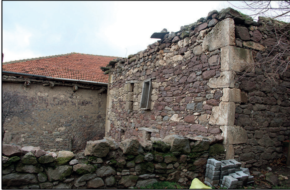
Fotoğraf 33: Duvar Köşesinde Kaba Yonu Taş / Rough Cut Stone in Wall Corner
