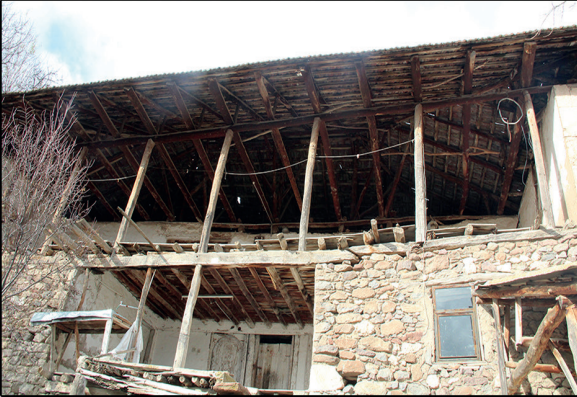
Fotoğraf 59: Çatı / Roof
