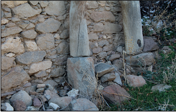
Fotoğraf 35: Taş Üzerine Oturtulan Ahşap Dikmeler / Wooden Pillars Sitting on Stone
