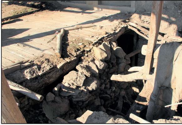
Fotoğraf 40: Geçmesiz Ahşap Kaplama / Impermeable Wood Covering
