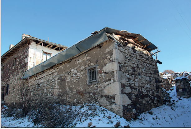
Fotoğraf 87: Metal Levha Çatı Kaplaması / Metal Sheet Roof Covering
