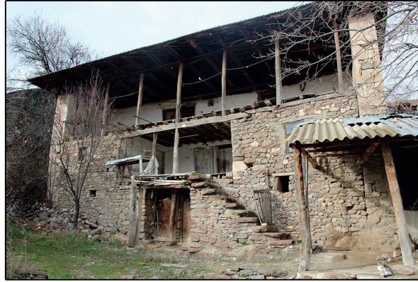
Fotoğraf 6: Güney Cephesi - Sofa / South Facade - Sofa
