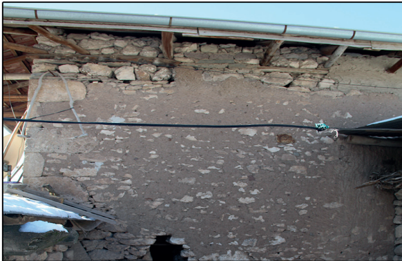
Fotoğraf 36: Saman Karışımı Çamur Duvar Sıvası / Straw Mix Mud Wall Plaster
