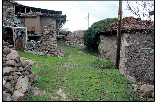
Fotoğraf 15: Zemin Kat Duvarları / Ground Floor Walls
