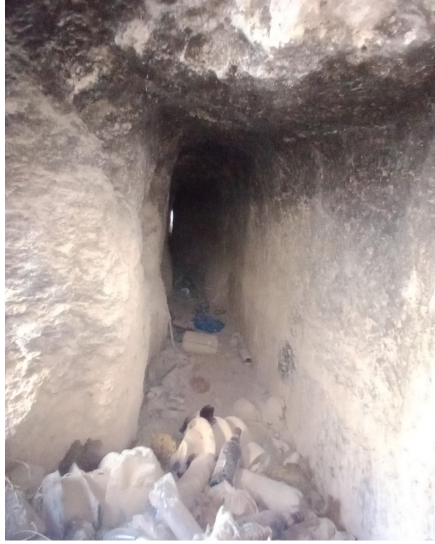
Resim 6: Birinci (Roma) Su Yolu Tüneli (Eyceli Civarı)
