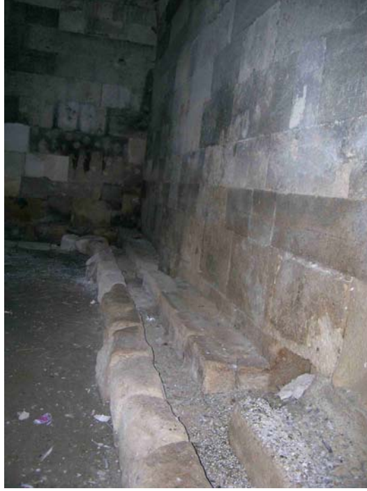
Foto 3: Aksaray Sultan Hanı, güneydoğu köşede yer alan tuvalet mekânı kanallardan detay.
