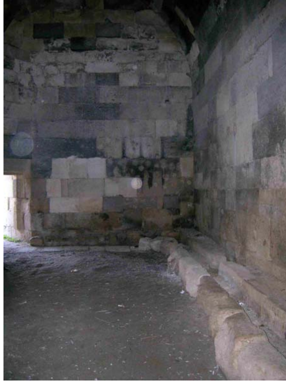
Foto 2: Aksaray Sultan Hanı, güneydoğu köşede yer alan tuvalet mekânı genel görünüş.
