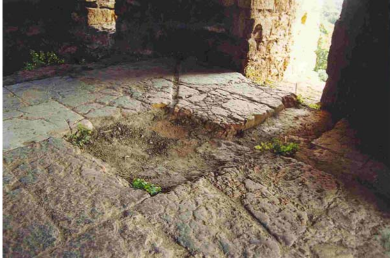
Foto 10: Alanya Sedre Köşkü, üst kat havuz ve su kanalları.
