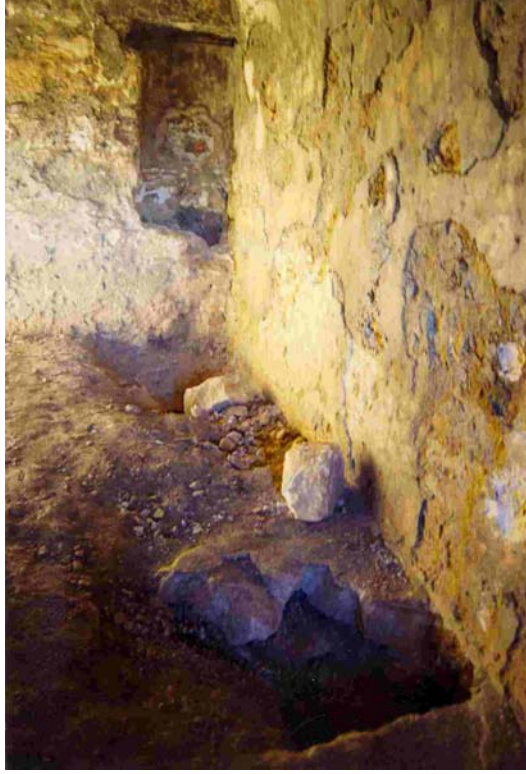
Foto 9: Alanya Sedre Köşkü, üst kat kuzeybatı köşedeki mekân.
