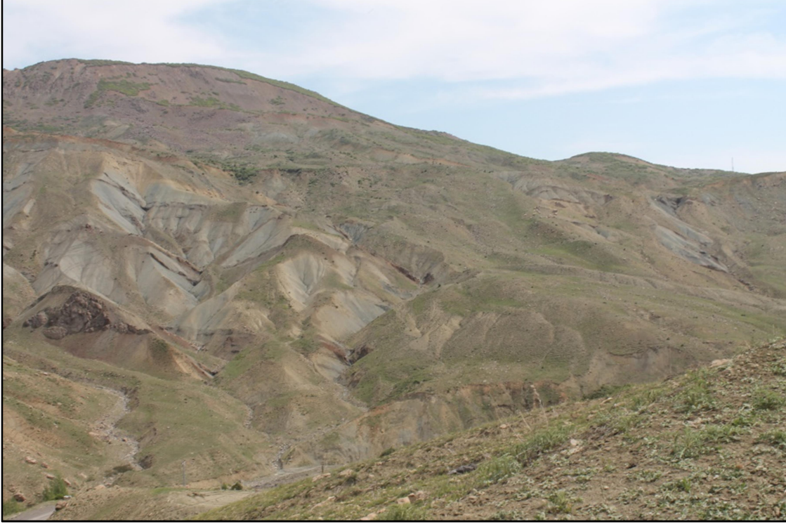
Foto 4. Bingöl Çayı Havzası'nın kuzeyinde killi yapıya bağlı olarak heyelanlar görülmektedir.
