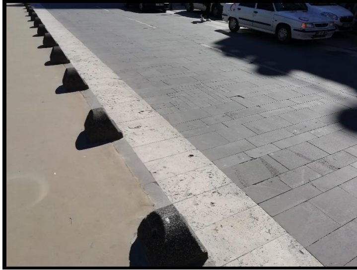
Şekil 3. Trabzon Bulvarı Araç Yolu Döşemesi
