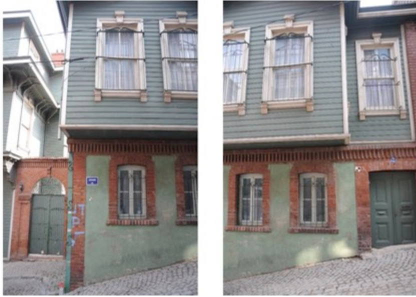
Şekil 7: Güney batı cephesi 2008 (İstanbul Yenileme Alanı K.T.V.K.K, Arşivi, 2015)
