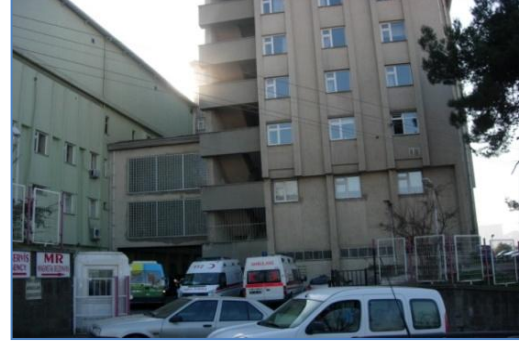
Şekil 16. Hastane binası ve acil girişi
