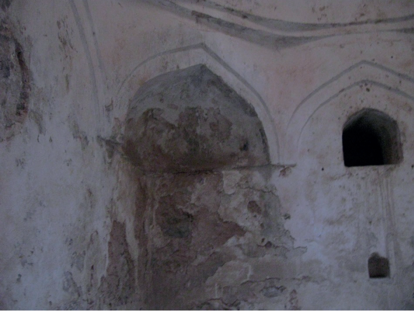
Res.28- Erkekler kısmı sıcaklığında tromp
