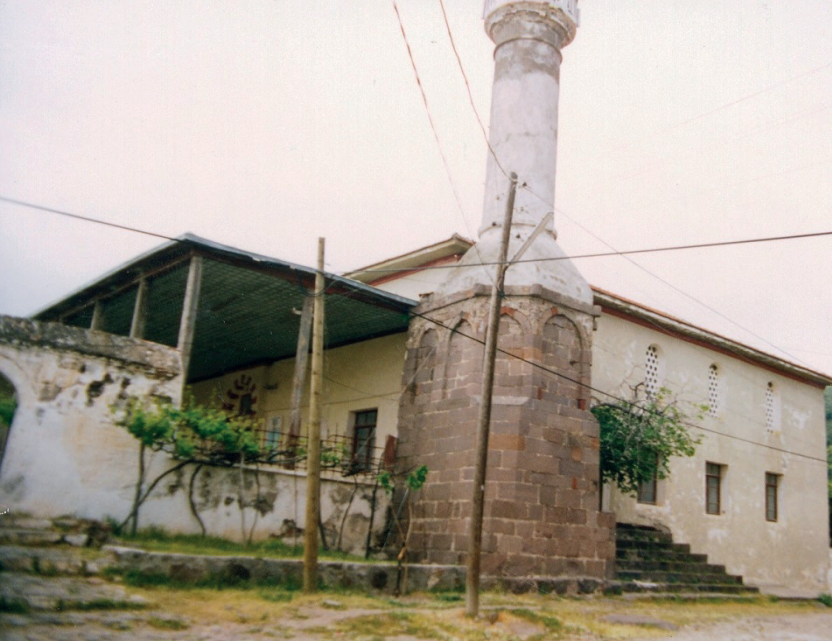
Res.14- Batı cephe, onarım öncesi (VGMA)
