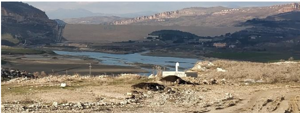
Şekil 8. Kralkızı barajı mansap gövde görünüşü
