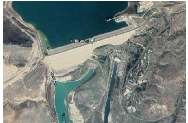
Şekil 2. Kralkızı barajı gövdesi görünümü [8].
