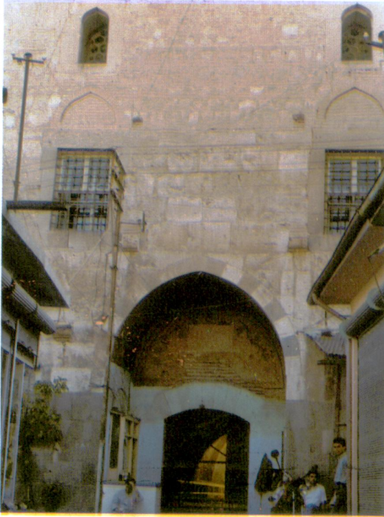
Resim 4 - Bor Sokullu Mehmet Paşa Camii ve bedestenin doğu taraftan görünüşü.
