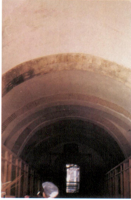
Resim 19 - Bor Sokullu Mehmet Paşa Bedesteni, iç mekândan görünüş.
