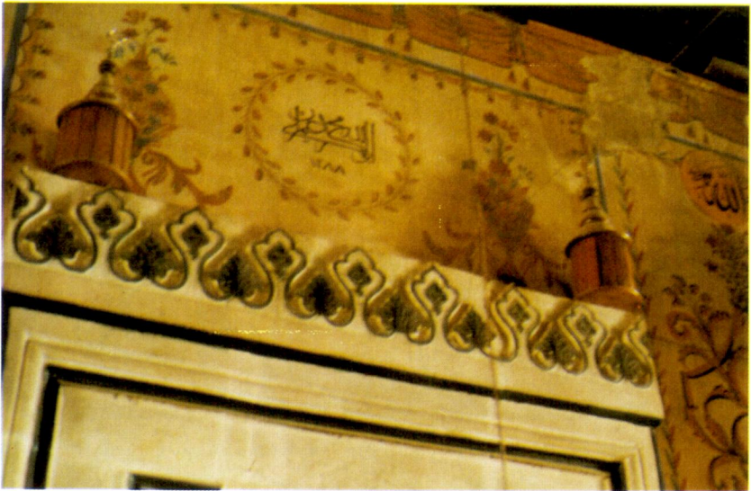
Resim 16 - Bor Sokullu Mehmet Paşa Camii, onarım kitabesi.
