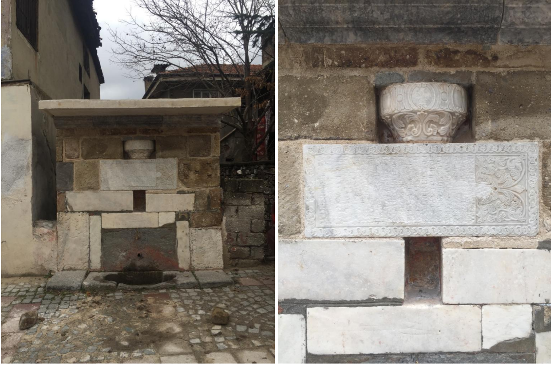
Şekil 16. Aldanzade Hacı Osman Çeşmesi restorasyon sonrası kuzeybatı cephesi ve devşirme sütun başlığı
