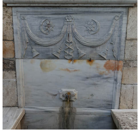
Foto 9: Çeşmenin güney cephesinden ayrıntı.
