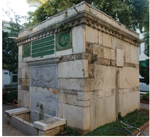
Foto 11: Çeşmenin güney ve doğu cephesi.
