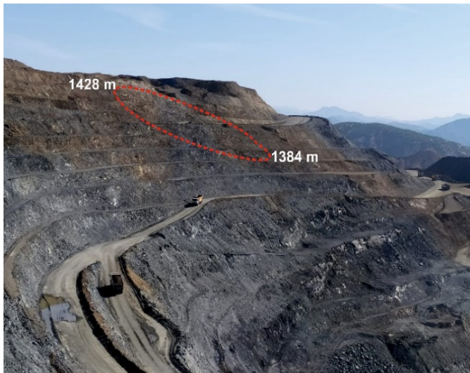
Şekil 7. Taç noktası 1428 m topuk noktası 1384 m olan şev duraysızlığı (fillit)
