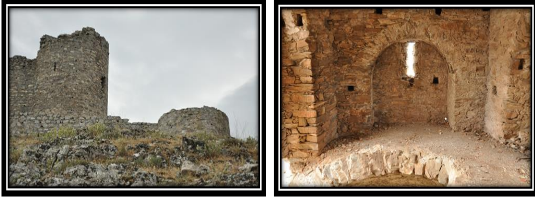
Kuzeybatı yönünden dış sur duvarı ve yuvarlak planlı destek kuleleri ve Batı yönündeki yuvarlak planlı kulenin iç mekanı
