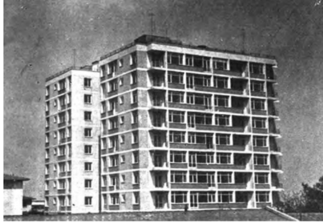
Şekil 20. 1965 Apartman bloğu örneği (Koca, 2015, s. 23)
