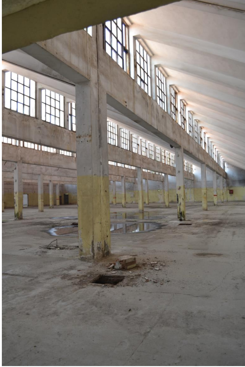
Şekil 7 Ana üretim binası çatısındaki pencerelerden sağlanan doğal ışık.
