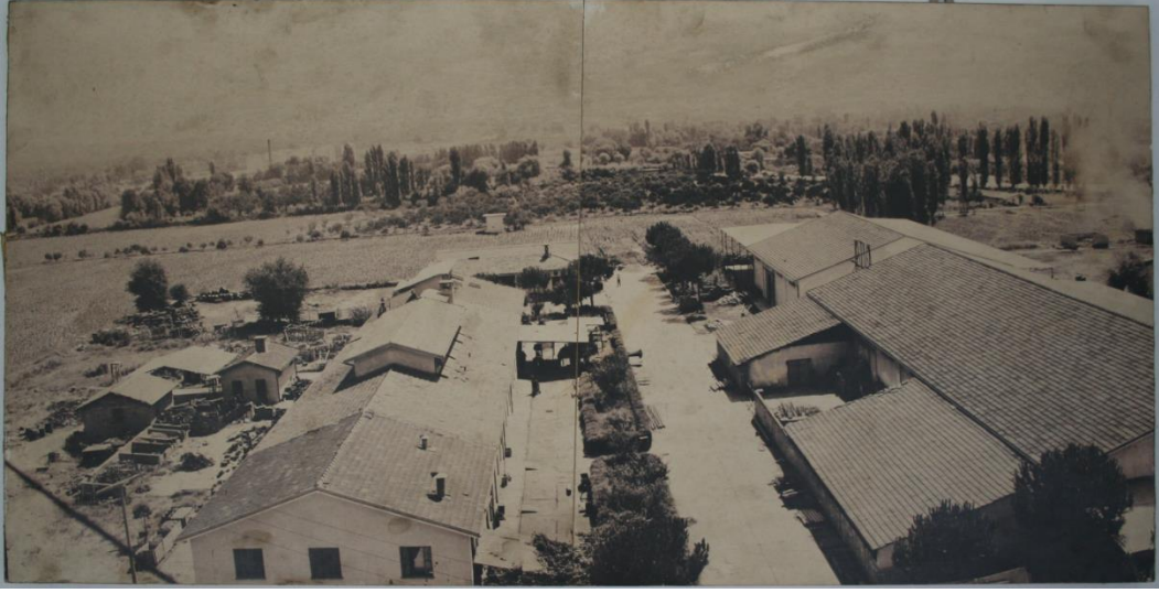
Şekil 10 Teknik yapılardan görünüm, 1970'ler (solda depolar, depoların bittiği yerde itfaiye binası, sağda elektrik atölyesi) (Aydın Büyükşehir Belediyesi Arşivi)
