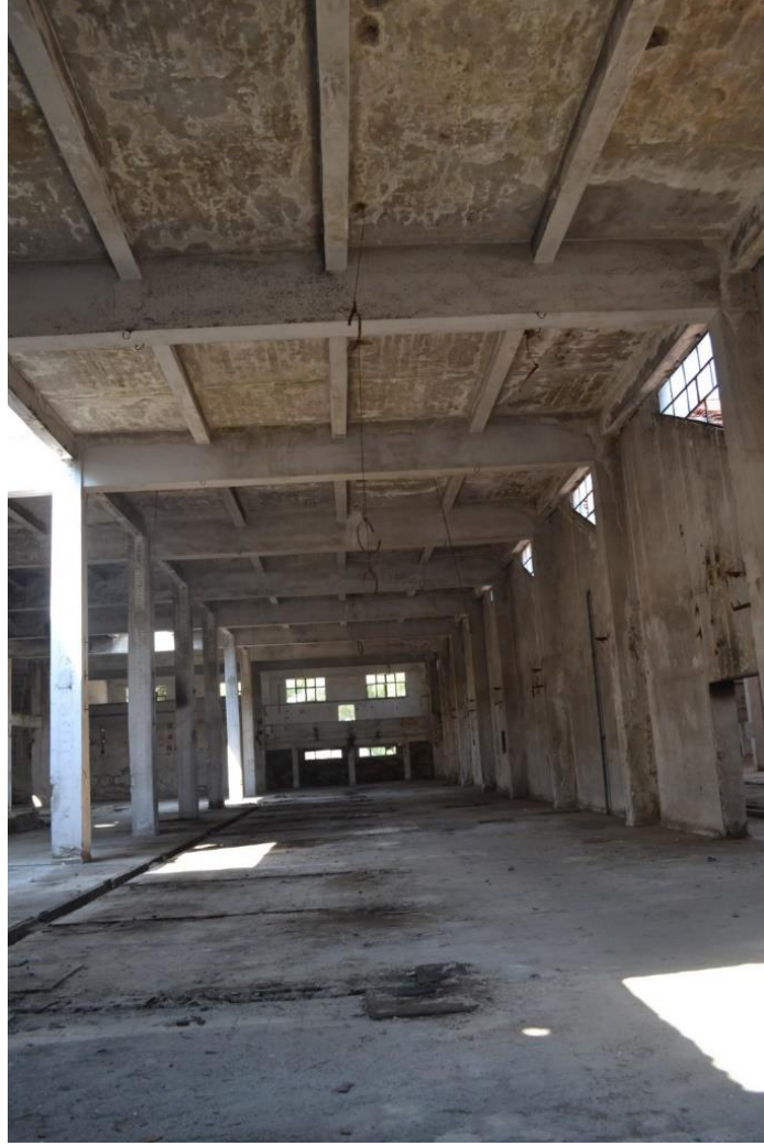
Şekil 8 Ek üretim binası.
