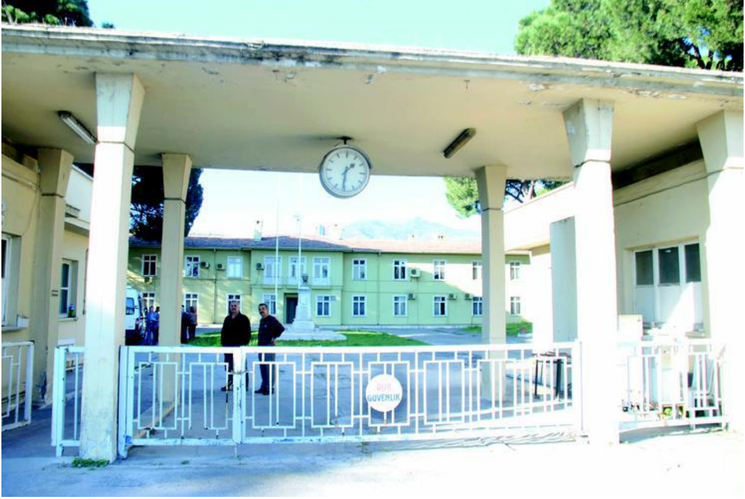
Şekil 20 Ana giriş kapısı (nizamiye) ve üretimin durduğu zamanı gösteren saat, 2005. (M. Özçakır Arşivi)
