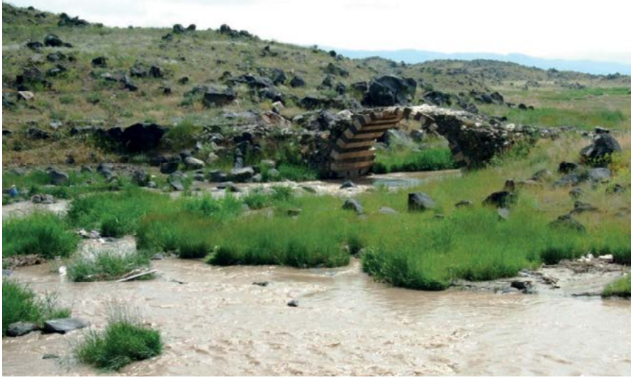
Fig. 7. Alaköprü ve Sarısu Nehri
