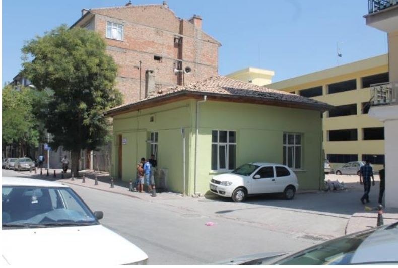
Foto. 1: Kınacı Sokağı (Mihmandar Mahallesi-Mahmud Bey) Mescidi
