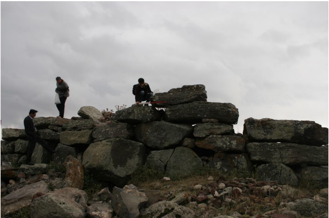
Foto 4: Yağlıca Kalesi Sur Duvarı
