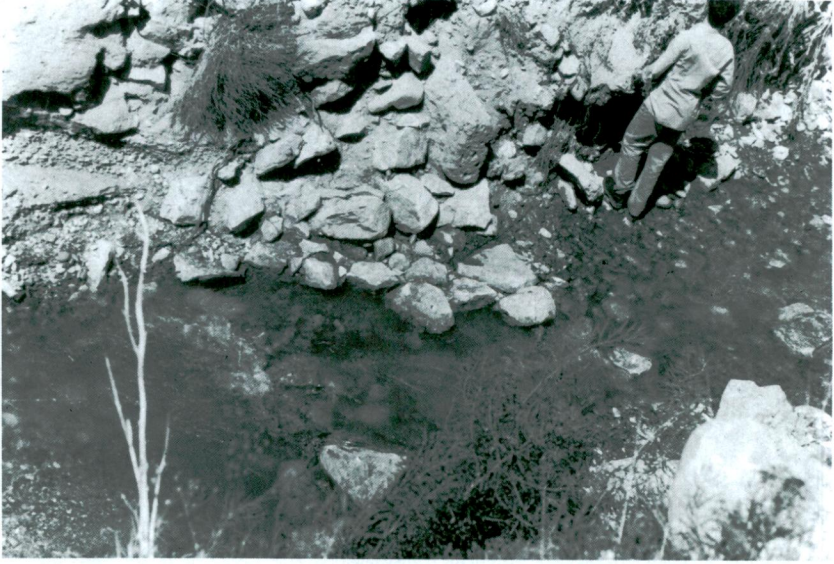
Resim 13 – Orta kısmı parçalanmış barajın duvar temelleri üzerinden akan Hırsız Deresi.
