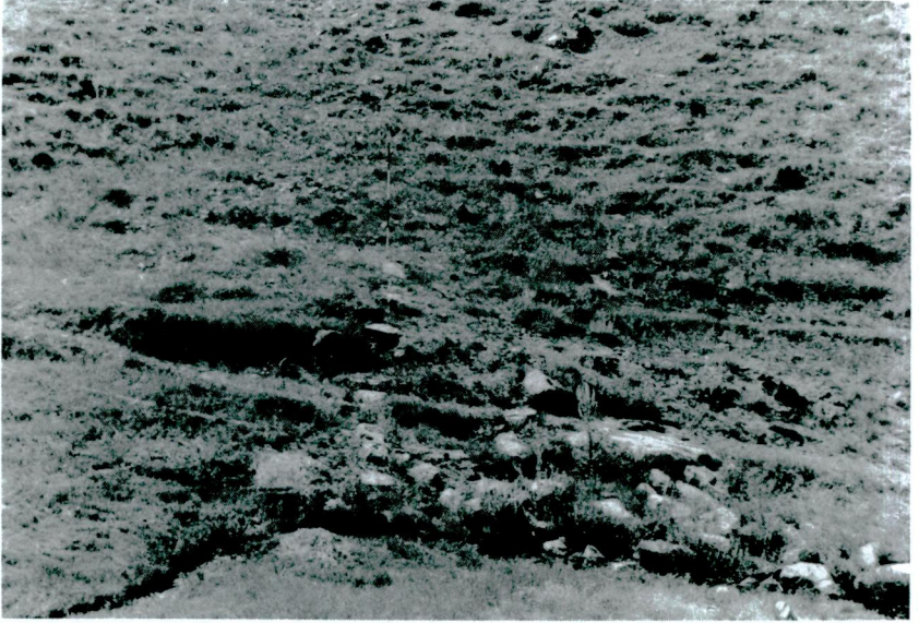
Resim 18 – Sular tarafından parçalanmış Arç Barajı'nın temel duvarları.
