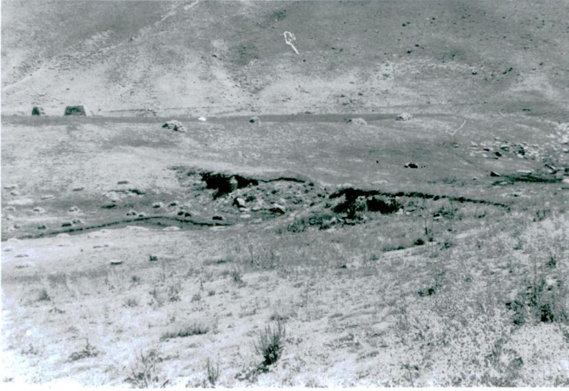
Resim 3 – Dar bir boğaza yapılan Aşağı Süphan Barajı.
