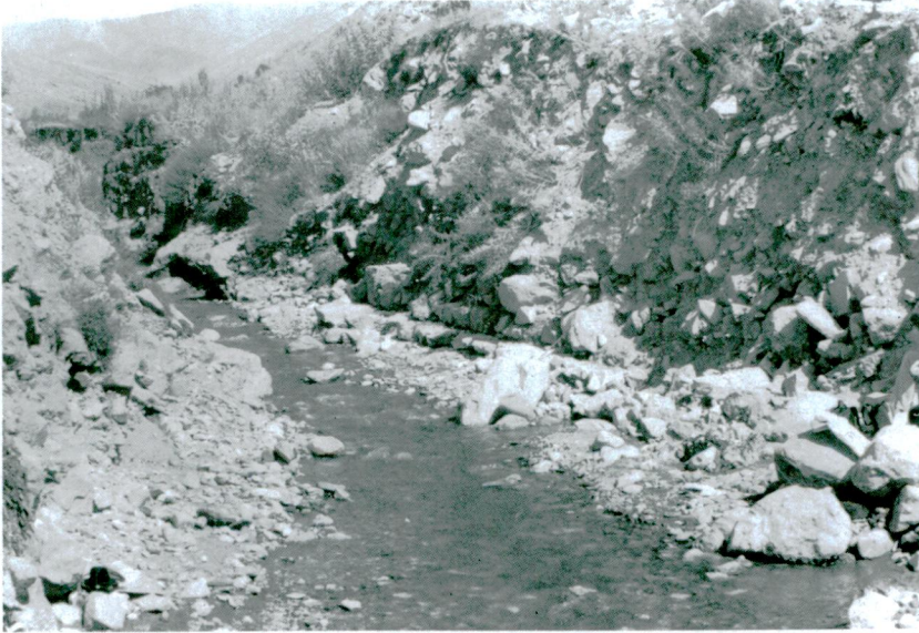
Resim 12 – Dar ve kayalık bir bođaza inřa edilen Hırsız Deresi Barajı.
