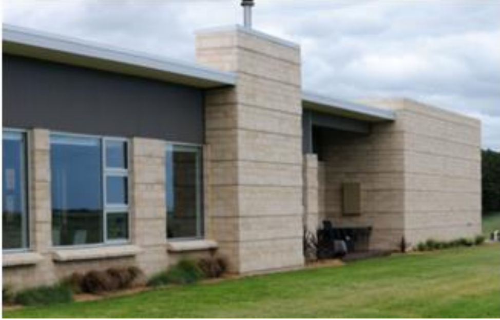
Şekil 10. Kereste beton (Timbercrete) malzemesinin yapıda kullanımı (URL 13)
