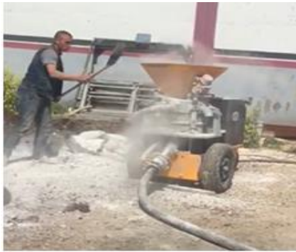
Şekil 13 a. Shotcrete makinesi kullanımı
