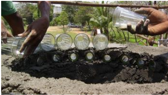
Şekil 3 a. Cam bardakların yapıda kullanımı
