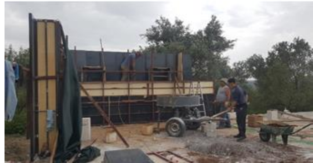
Şekil 11 b. Ahşap kalıp kullanımı (Aysel Tarım)
