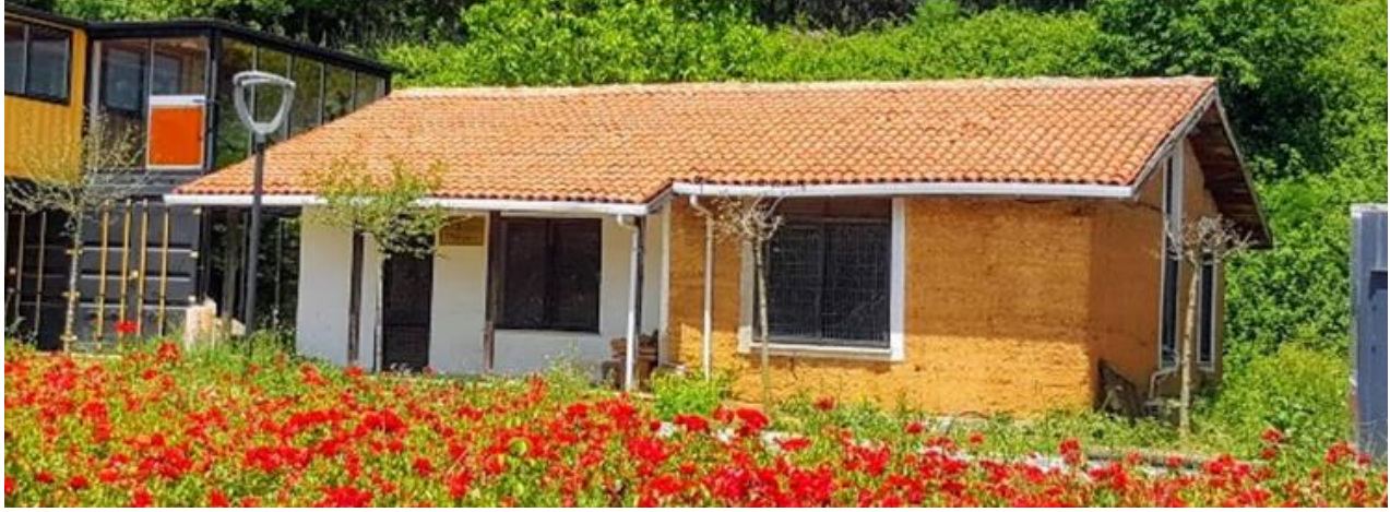
Şekil 17. İTÜ Ayazağa kampüsünde kerpiç yapı (Bilge Işık)
