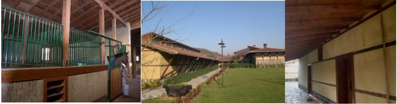
Şekil 15 a. Çatı örtüsü (Bektaş, 2019)
