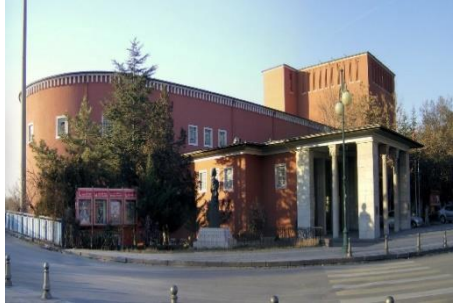
Görsel 24. Ankara Opera Binası (URL-24).
