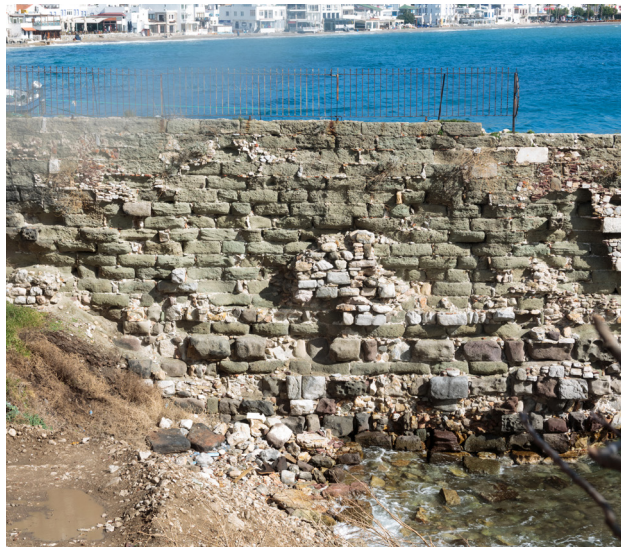
Şekil.21-1, 2, 3: Geçmiş dönem uygulaması olan çimento bağlayıcılı harç kullanılarak yapılan moloz dolgu örnekleri
