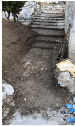
Şekil.25-1, 2, 3: Şapel / Kale Camii kuzey yönünde yapılan kazıda çıkan özgün basamaklar ve ısıtılmış ahşap (thermowood) döşeme uygulaması
