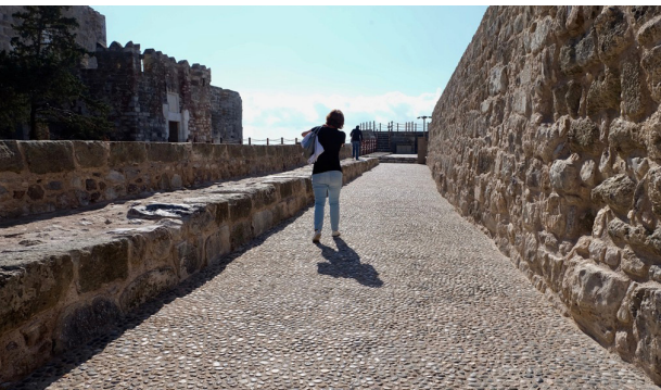
Şekil.26-1, 2, 3, 4: Batı sur seyirdim ve harçlı çakıl uygulanan zemin öncesi (üst 1/2), sonrası (alt 3/4) 14
