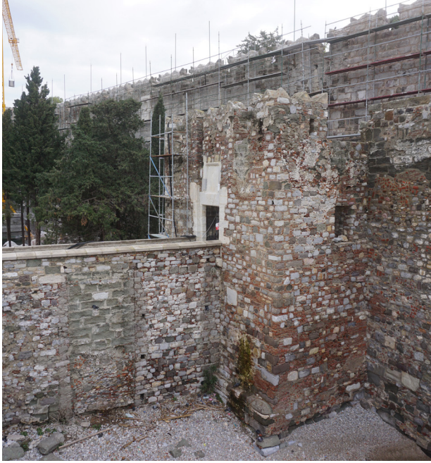
Şekil.10-1, 2: Geçit Kulesi (moloz taş dolgu uygulamasının en çok kullanıldığı yapı)
