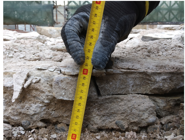
Şekil.11-1, 2, 3: Depo olarak kullanılan mekânlarda raflar için yapılan çimento sıva dolguları ve avlu zeminlerindeki döşeme katmanları
