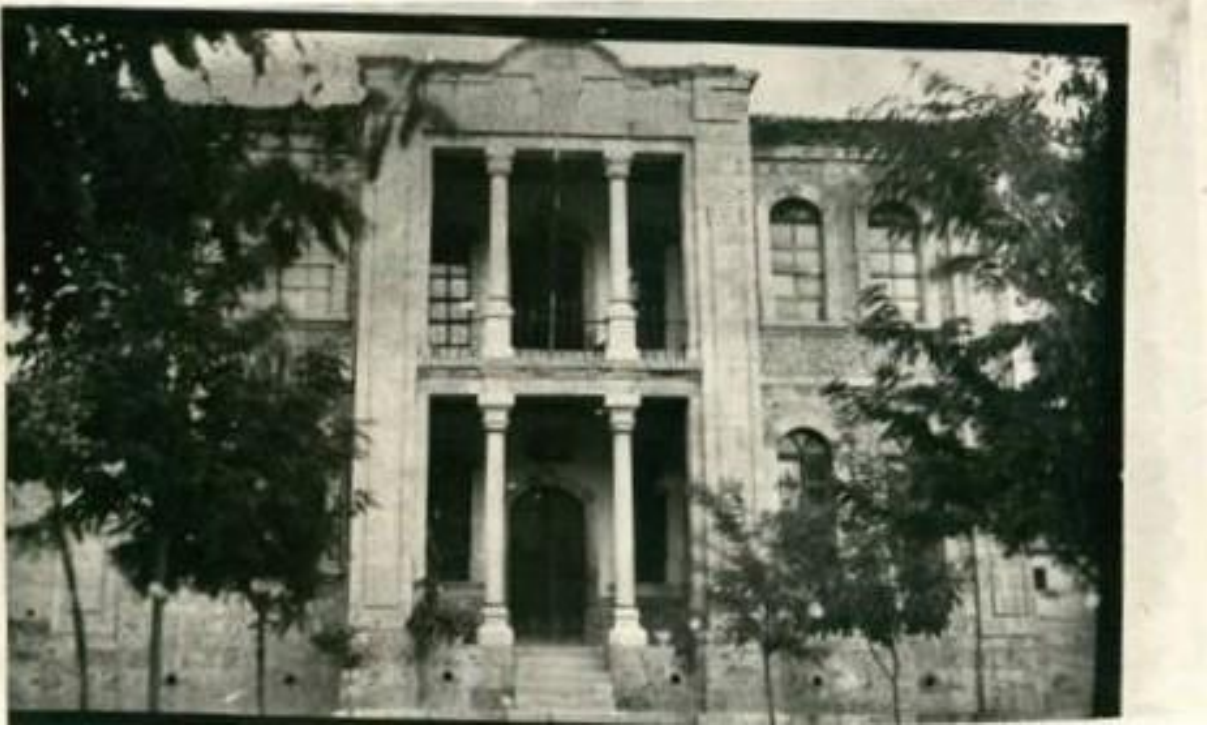
Figür 5: Bozkır Redif Deposu'nun ön cephesi ( www.bozkir.net )
