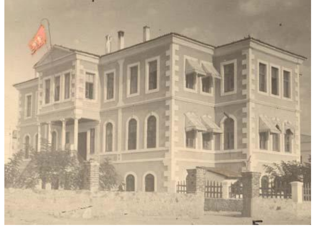
Figür 8: Taşköprü Hükümet Konağı (M. Topçubaşı, K. K. Eyüpgiller'den)
