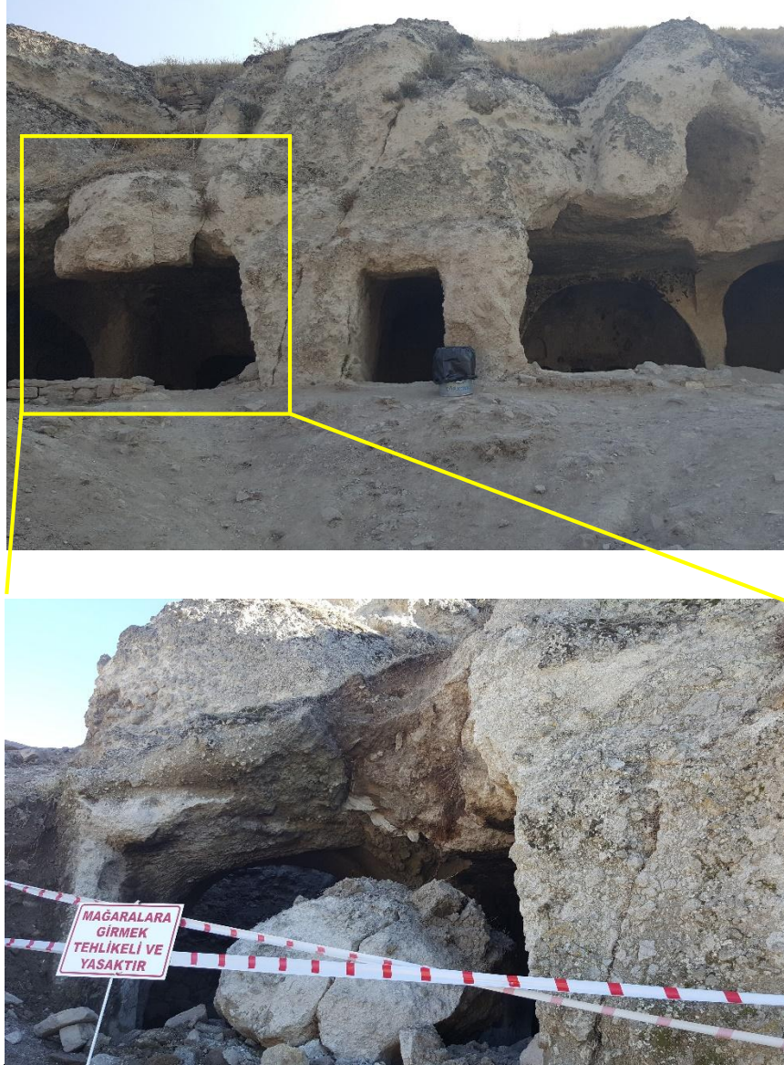
Şekil 1. Sille'deki antik kaya oyma yapılarından biri olan Koimesis Tes Panagias Kilisesi ve atmosferik koşulların etkisiyle aşırı bozunmaya maruz kalan hamurda kayada meydana gelen parçalanma ve kopmalar.
