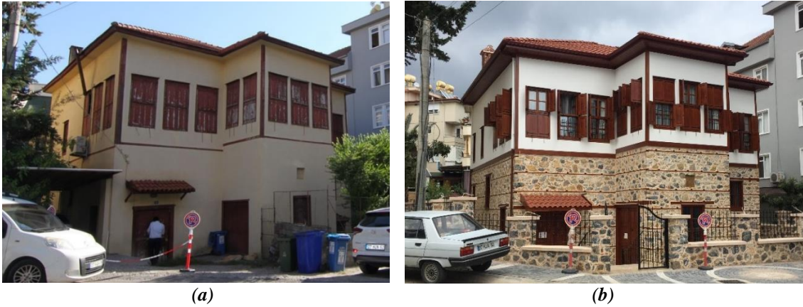
Şekil 10. Mustafa Çırpanlı Konutu (a) Onarım öncesi ve (b) Onarım sonrası.
