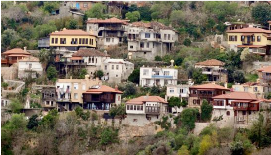
Şekil 6. Tarihi dokuyu oluşturan Alanya Geleneksel konutlarında cephelerin genel görünümü.
