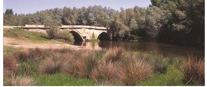
Şekil 1. Karabıyık köprüsü restorasyon öncesi görünüm
