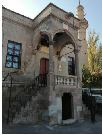
Şekil 16. Giriş cephesi görünüm
