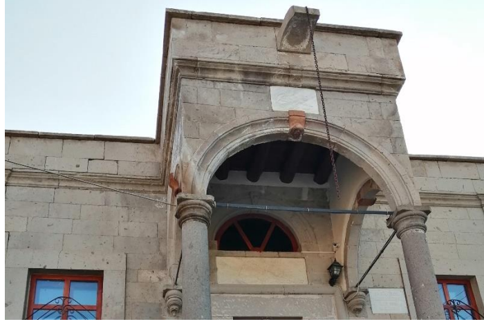
Şekil 17. Giriş revağı yakın görünüm
