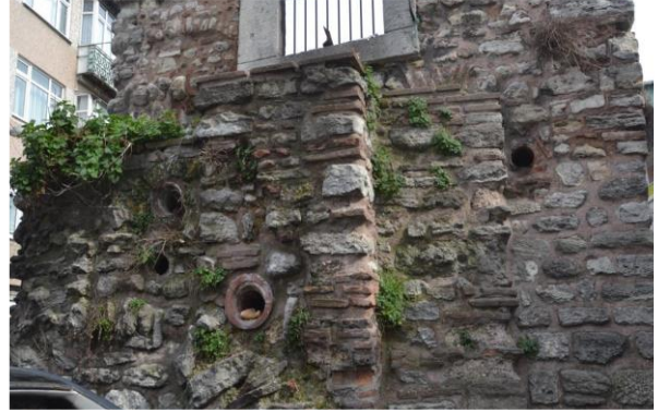
Şekil 7. Valens (Bozdoğan) Kemer ve suyu taşıyan künkler (2015).
