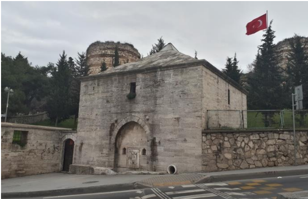
Şekil 13. Edirnekapı'dan Ayvansaray'a inen yol üzerindeki Eğrikapı Maksemi (2020).
