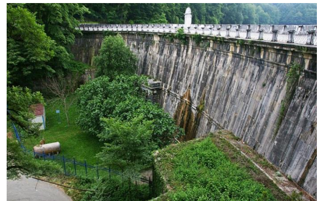
Şekil 5. 1839 yılında inşa edilen II. Mahmud Bendi (Yeni Bent) [18].
